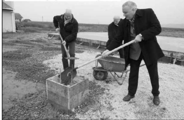
Građevinski radovi na montažnim stambenim jedinicama: Polaganje kamena temeljca
