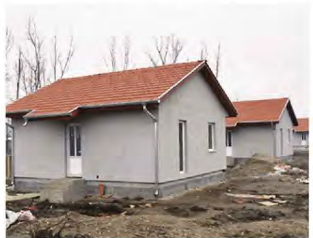
За монтажне куће треба имати земљиште
