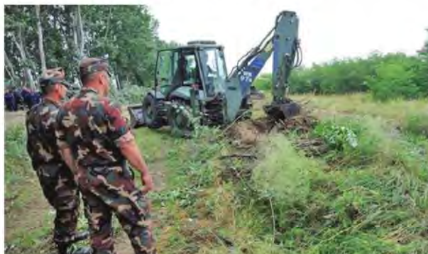
RADOVI U MORAHALOMU Ograda će biti visoka 4 m i dugačka 174 km
