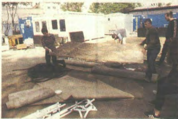
АКЦИЈА Волонтери уклањају опрему
