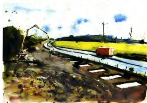
„Veliki zid Kalea“ u izgradnji
